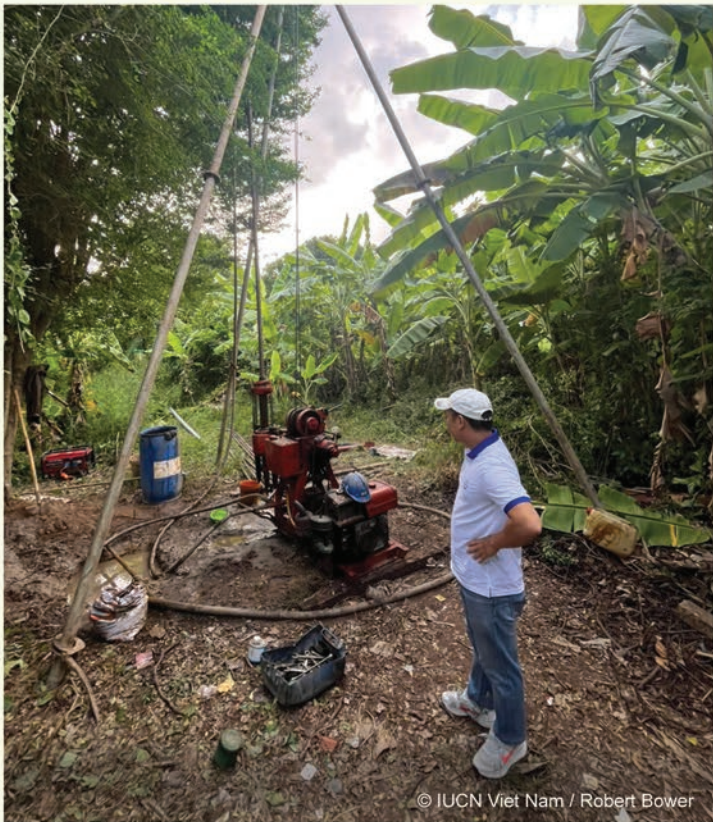
Lắp đặt giếng quan trắc Asen trong nước ngầm tại An Giang, Việt Nam
