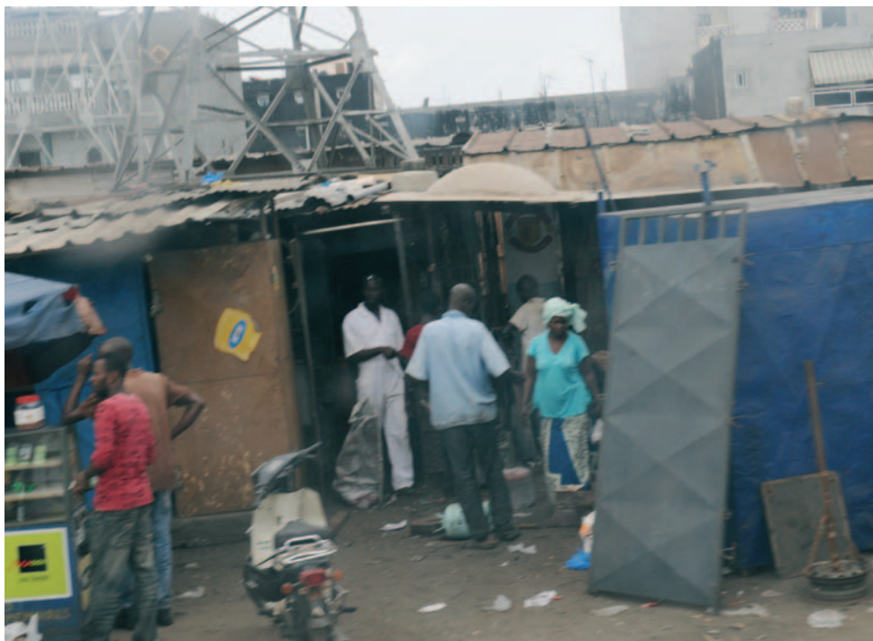
Un des « quartiers précaires » de Koumassi où il est difficile d'avoir accès à l'eau potable
