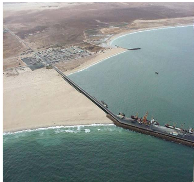
L'érosion constatée au Sud de la jetée du Port de Nouakchott détermine un risque important d'intrusion marine menaçant des quartiers urbains situés au-dessous du niveau marin.
