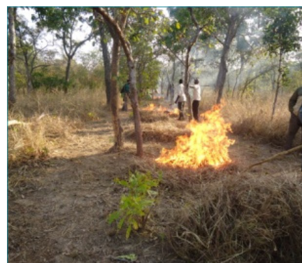
Chantier école: Bande d'arrêt de feu
