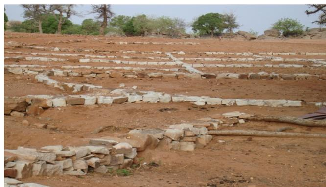
**Photo 13** : Dispositif de lutte antiérosive (cordon pierreux)/ Zone de Bandiagara
