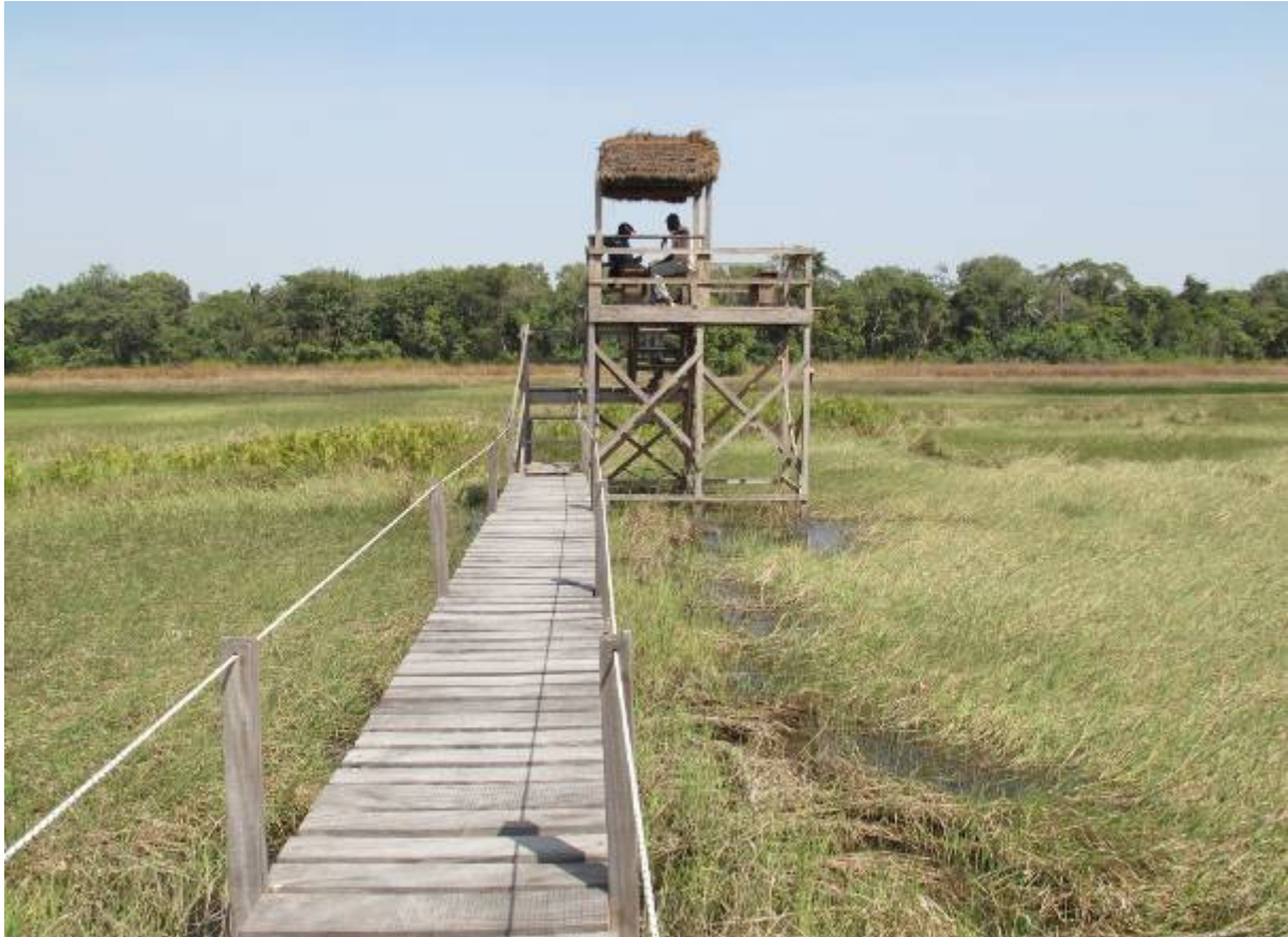
Passerelle et Mirador au Parc Naturel des Lagoas de Cufada (Photo F. Airaud)
